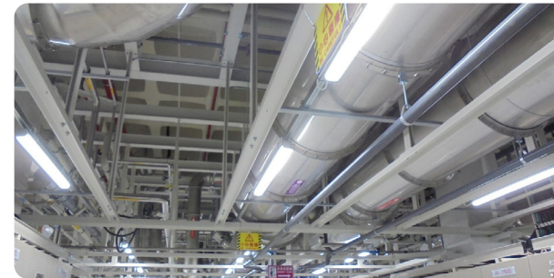
■ 不鏽鋼材質風管設置，降低火載量與避免延燒
